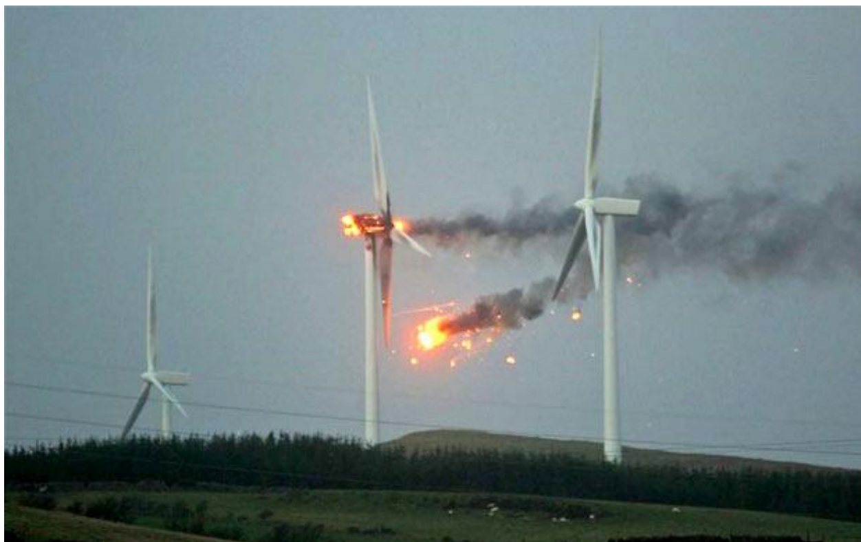
Rys. 12. Pożar turbiny wiatrowej [9].
